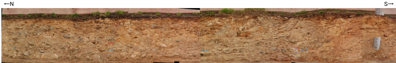
写真(35m盤法面)
