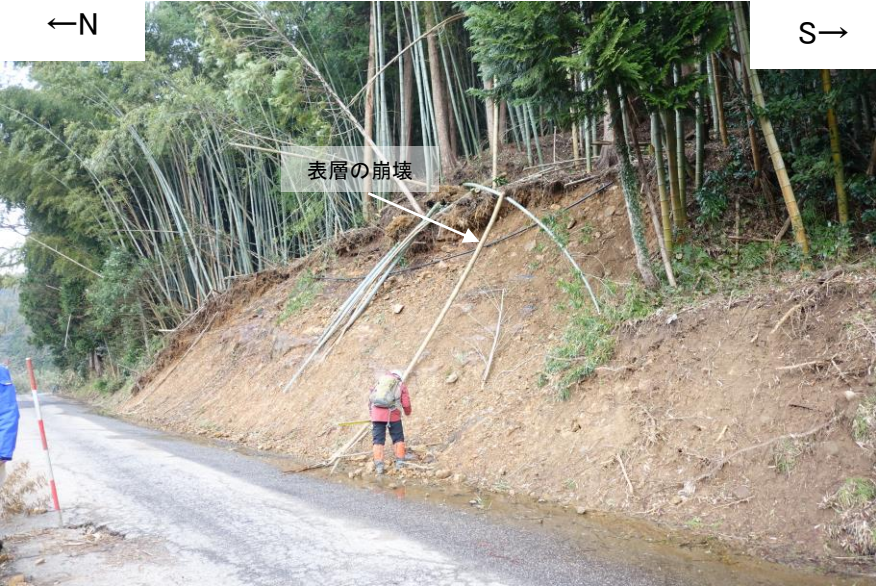
写真 地点⑤(2024年3月14日撮影) 斜面の表層が崩壊している。東方向を望む。
