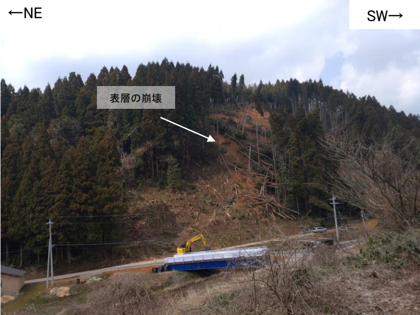
写真 地点④(2024年3月14日撮影) 富来川左岸沿いの斜面が崩壊している。北西方向を望む。
