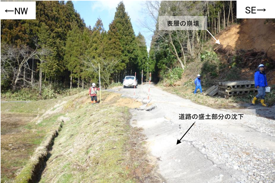
写真 地点①(2024年3月14日撮影) 道路の盛土部分が北西側(谷側)に沈下している。また、南東側斜面の表層が崩壊している。北東方向を望む。
