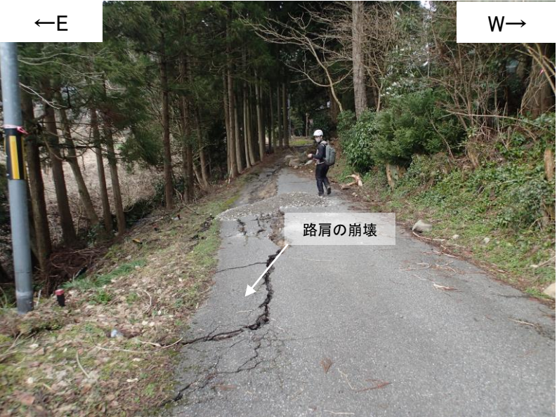
写真 地点③(2024年3月14日撮影) 路肩が東側(谷側)へ崩落している。南方向を望む。
