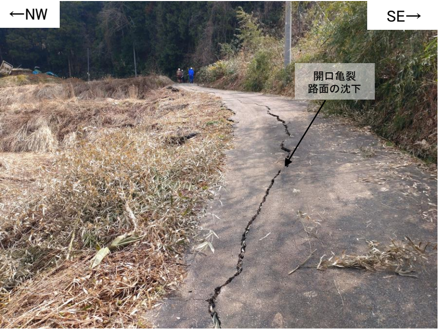
写真 地点⑥(2024年3月14日撮影) 道路に開口亀裂が認められ、路面が一部沈下している。北東方向を望む。
