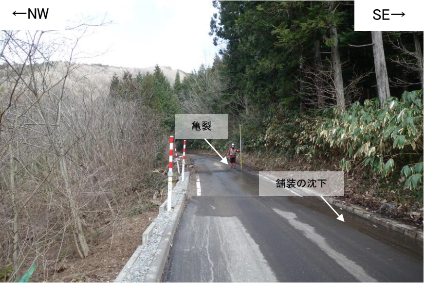
写真 地点②(2024年3月14日撮影) 道路の沈下や亀裂が認められる。北東方向を望む。
