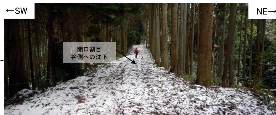
写真 ⑥地点(稲敷西方南地点)(2024年1月15日撮影) リニアメント通過部の鞍部を横切る道路盛土に円弧状の開口割目・谷側への沈下が認められる。北西を望む。
