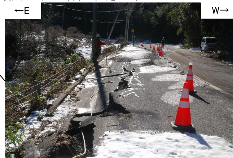
写真 ②地点(大釜西方・国道249号地点)(2024年1月11日撮影) 道路盛土部分に円弧状の変状が認められ、谷側に沈下している。南方方向を望む。
