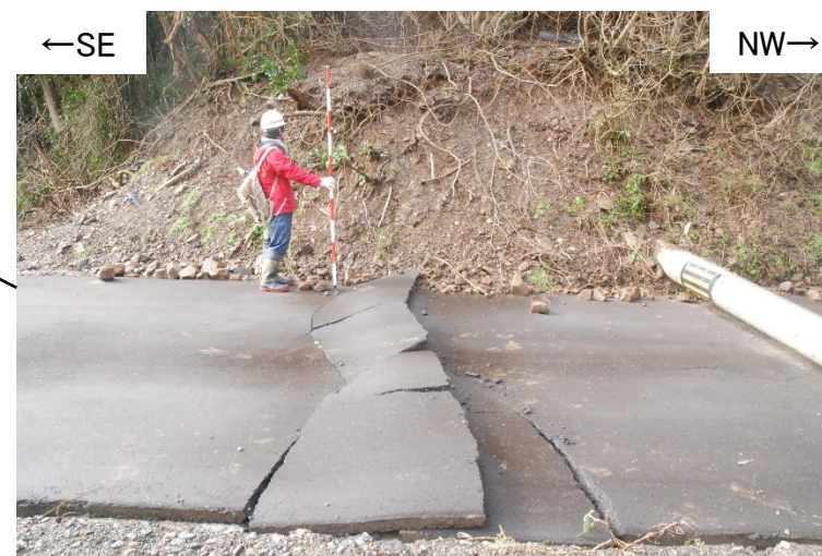
写真 ①地点(大釜西方地点)(2024年1月11日撮影) 南東側の舗装が北西側へ乗り上げるような圧縮性の変状が認められ、これは酒見断層の変位センス(西側隆起)と異なる。南西方向を望む。
