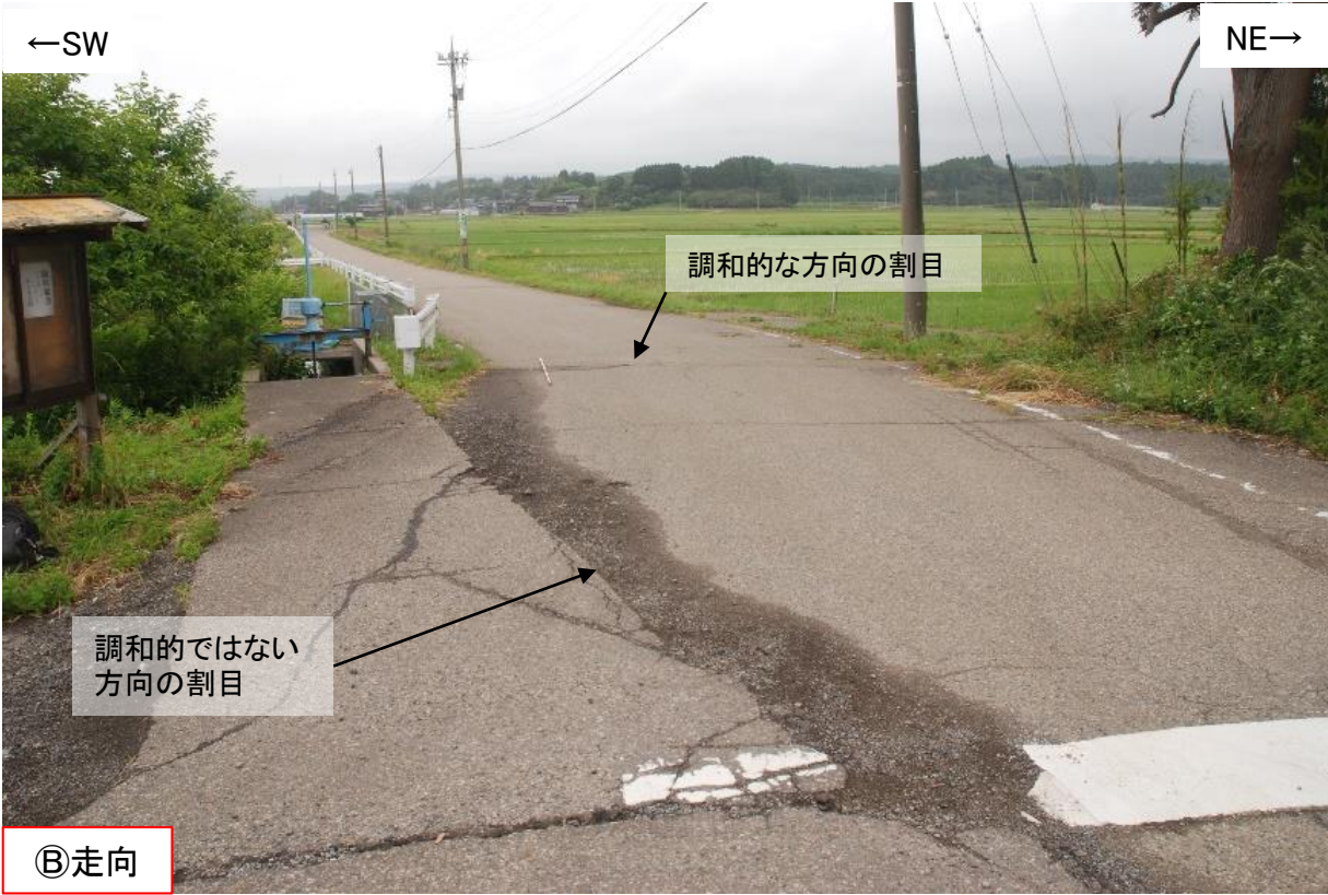
写真66(2025年6月13日撮影) 北西方を望む。富来川南岸断層の走向と調和的な方向の割目と, 調和的ではない方向の割目が認められる。
