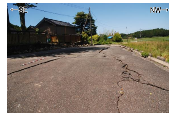
④地点(2024年5月29日撮影) 円弧状の開口亀裂を伴った北西落ちの変状が認められる。
