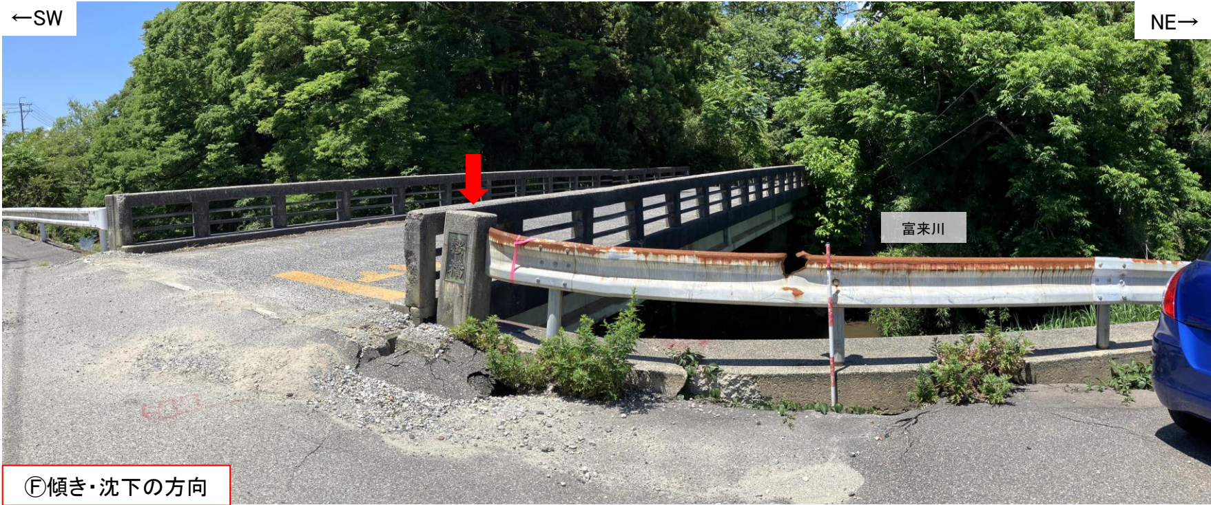
写真57(2024年6月19日撮影) 富来川左岸から西方を望む。路肩が富来川方向へ崩落し、橋柱(赤矢印)が富来川方向へ傾く。
