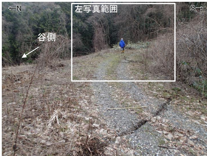
⑦地点-2(2024年2月2日撮影) 北落ちの変位(左写真)の西方にも変位が認められ、両者は 谷側に開いたハの字状(円弧状)に分布する。
