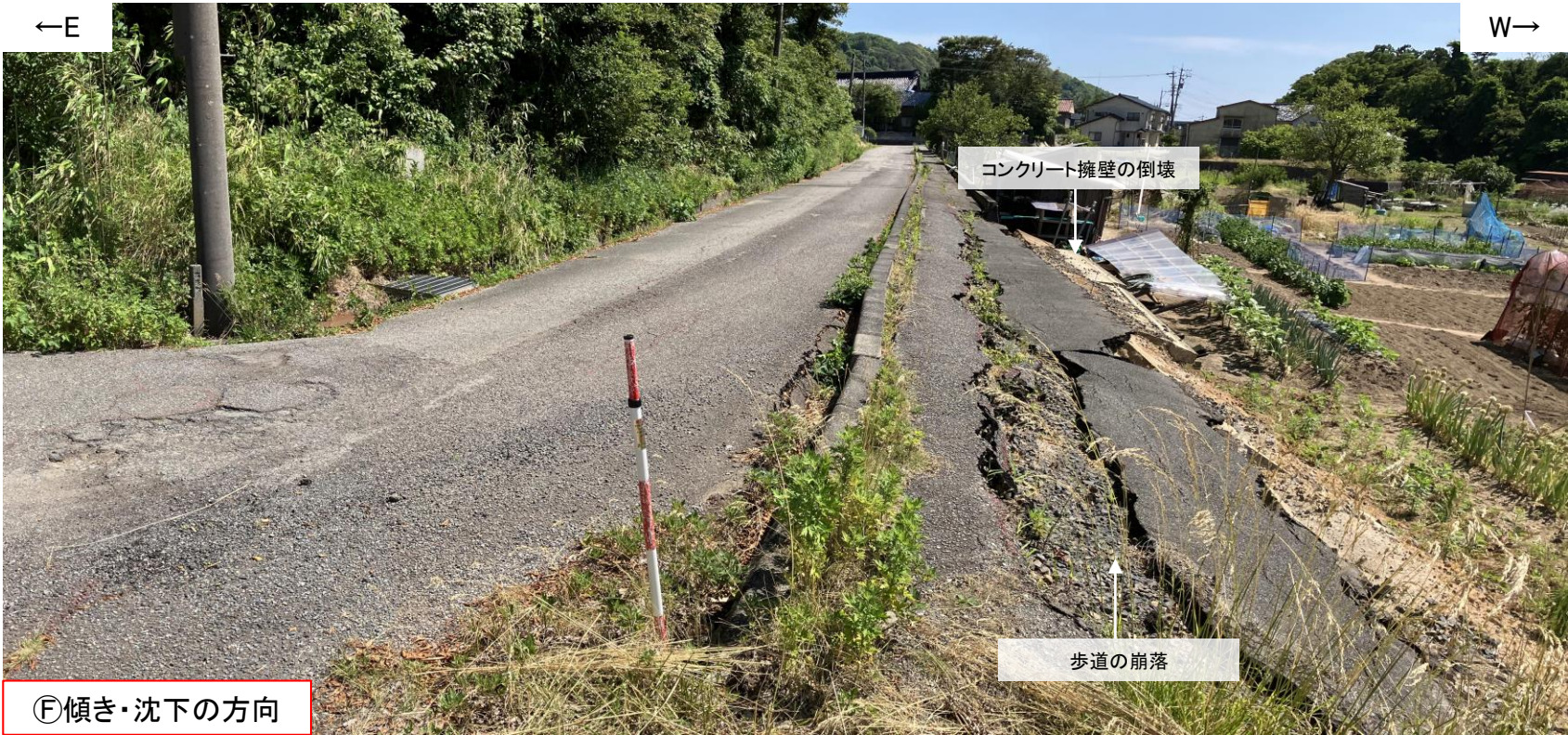
写真63(2024年6月19日撮影) 南方を望む。歩道が富来川方向(耕作地側)に崩落し、耕作地との境界に建付けられていたコンクリート擁壁が富来川方向(耕作地側)へ倒壊している。
