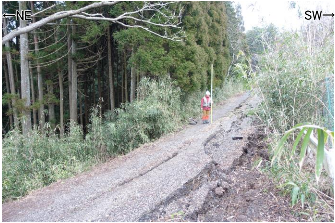
⑦地点-2(2024年2月2日撮影) 北落ちの変位(左写真)の西方にも変位が認められ、両者は 谷側に開いたハの字状(円弧状)に分布する。
