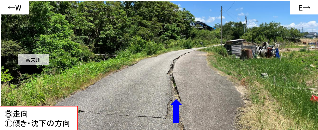
写真60(2024年6月19日撮影) 富来川左岸から北方を望む。 富来川南岸断層の走向と調和的な方向(NE-SW方向)の開口割目(青矢印)が認められ、 割目を境に、西側の路面は富来川方向へ傾き、東側の路面は低位の耕作地側へ傾いている。
