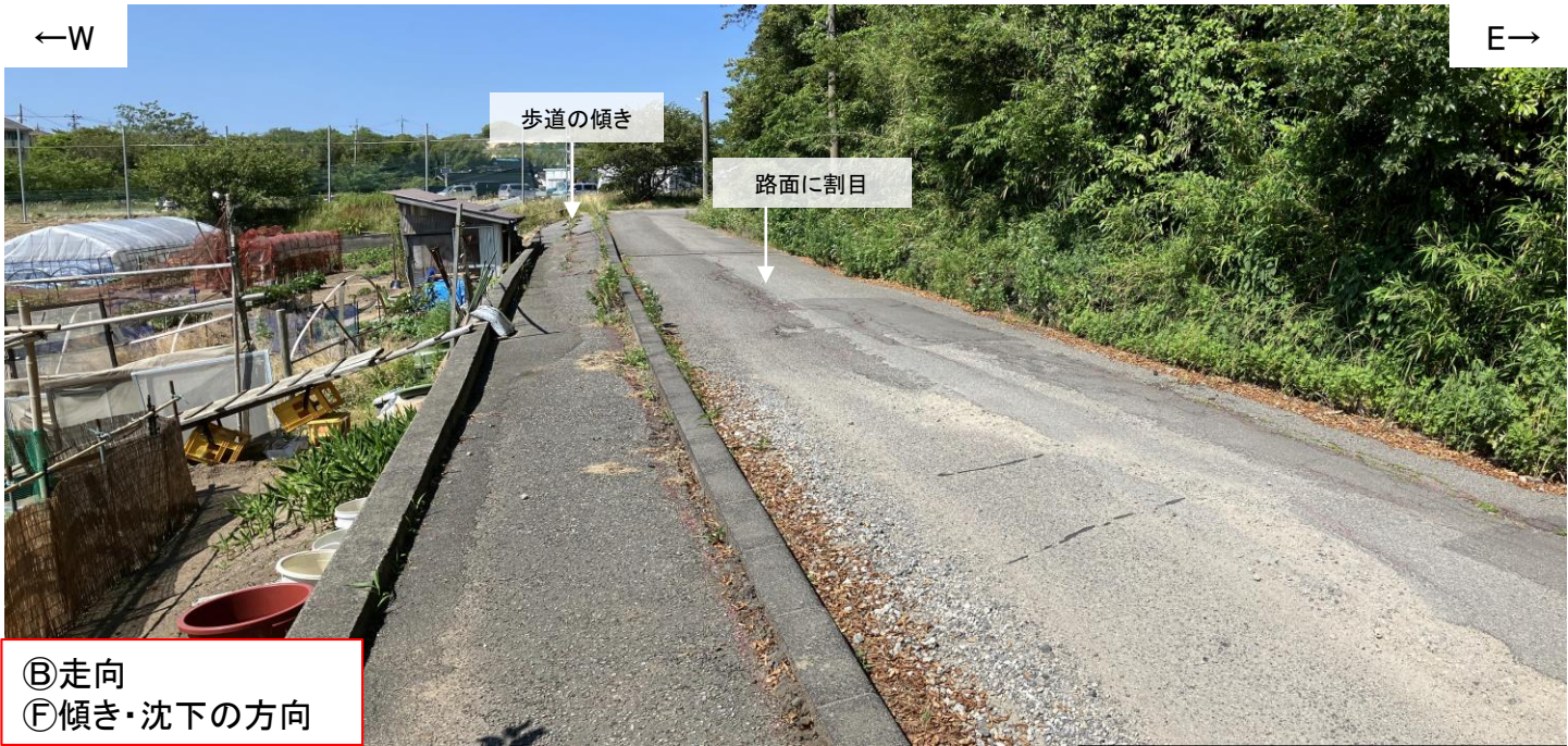
写真62(2024年6月19日撮影) 北方を望む。路面に富来川南岸断層の走向と調和的な方向の割目あり。 歩道が富来川方向(西側)に傾く。
