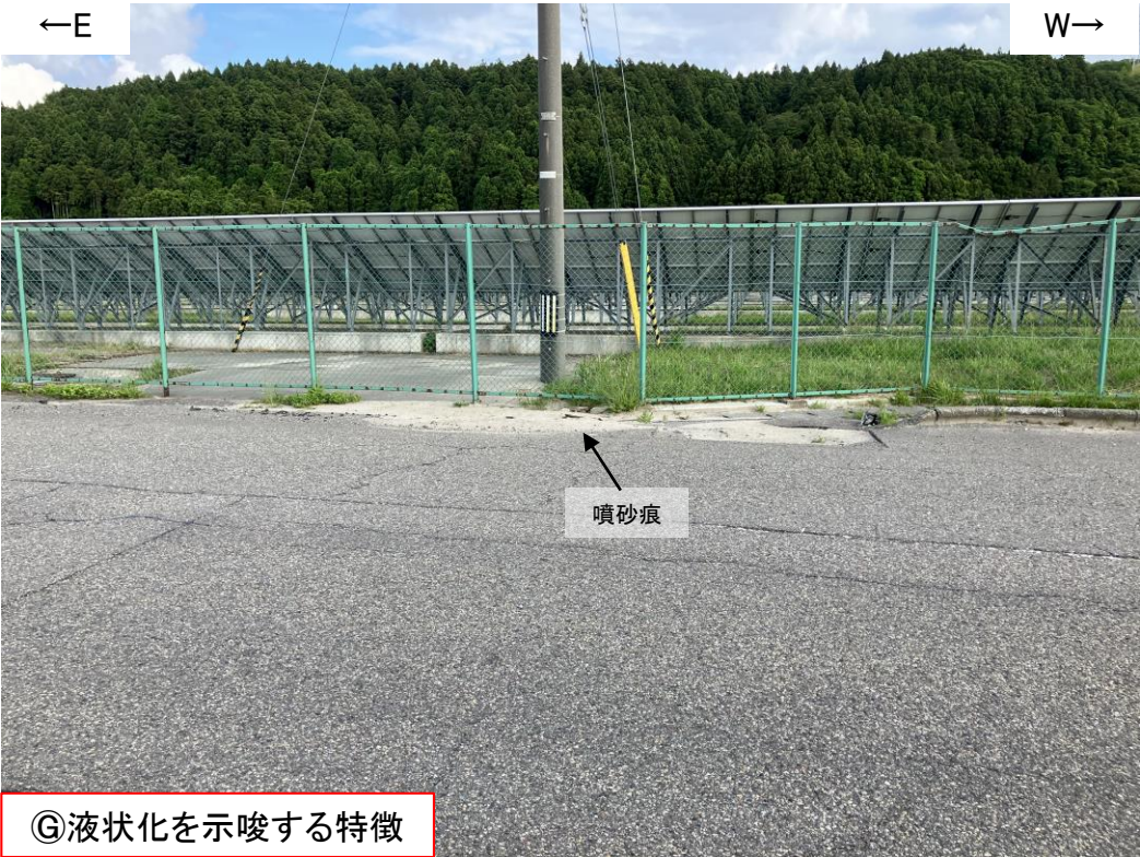
写真56(2024年6月4日撮影) 南方を望む。ソーラー施設北方に液状化を示唆する噴砂痕が認められる。
