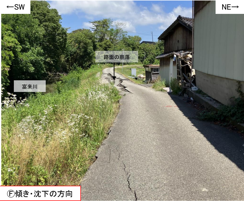
写真58(2024年6月19日撮影) 富来川左岸から北西方を望む。路面が富来川方向に崩落している。
