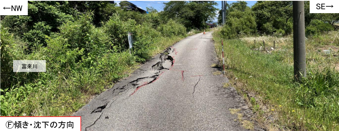
写真61(2024年6月19日撮影) 富来川左岸から北東方を望む。路面が富来川方向に崩落している。
