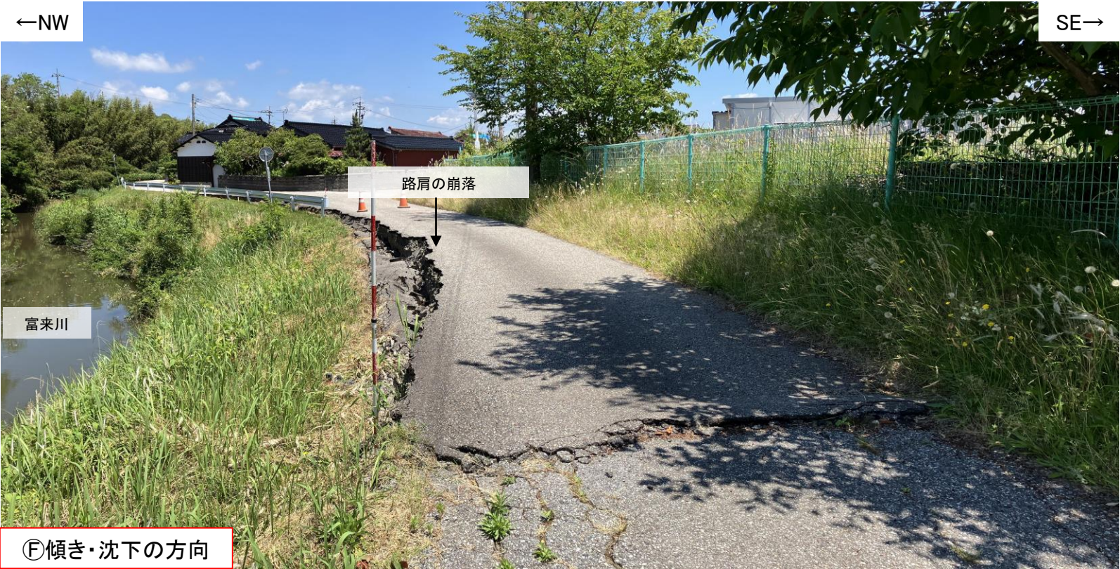
写真68(2024年6月19日撮影) 富来川左岸から北東方を望む。路肩が富来川方向に崩落している。
