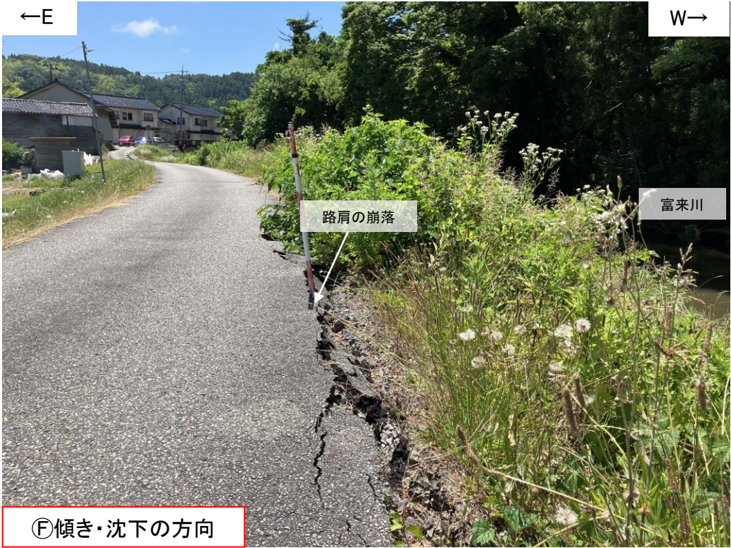
写真59(2024年6月19日撮影) 富来川左岸から南方を望む。路肩が富来川方向に23cm崩落している。
