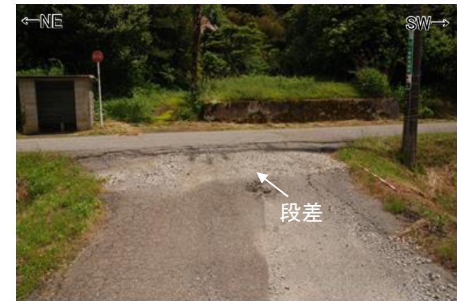
③地点(2024年5月30日撮影) 北東-南西方向の道路に接続するT字路接続部に 北西落ち(谷側落ち)の段差が生じている。
