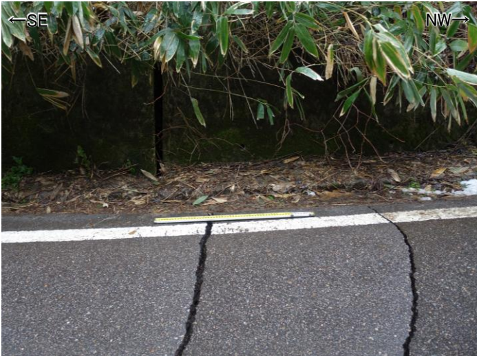
⑤地点(2024年2月2日撮影) 路面に僅かな北西落ちの変位を伴う開口割目が認められる。
