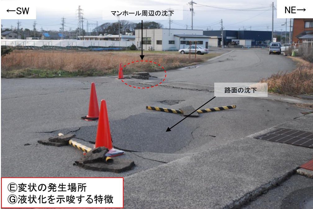
写真49(2024年1月17日撮影) 北西方を望む。マンホール周辺(赤破線)の沈下が認められる。また、路面も局所的に沈下している。これらの変状の発生場所は、盛土の縁辺付近である。
