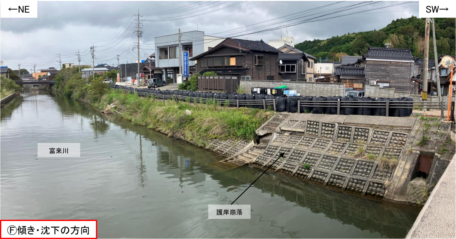
写真13(2024年6月4日撮影) 富来川左岸を望む。地盤(路面)の富来川方向への沈下や、護岸の崩落が認められる。
