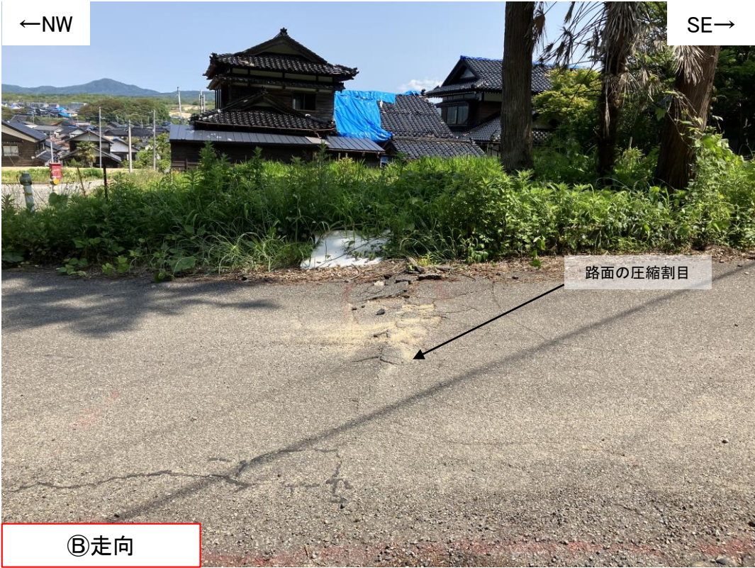
写真17(2024年6月4日撮影) 北東方を望む。路面に富来川南岸断層と調和的な方向の圧縮割目(N35E)あり。
