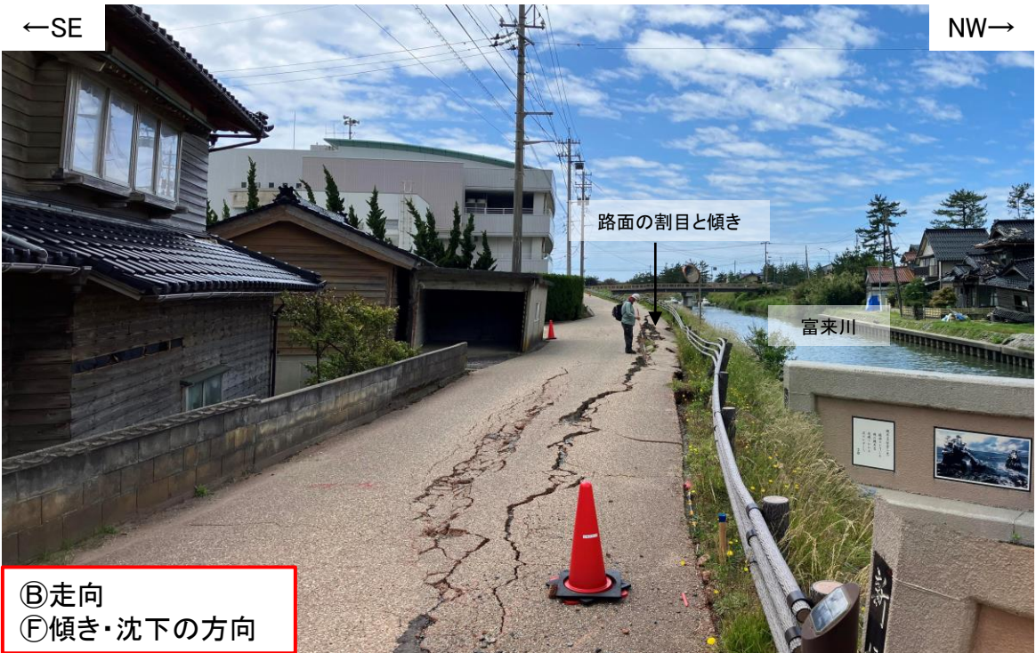
写真12(2024年6月4日撮影) 富来川左岸から南西方を望む。地盤(路面)の富来川方向へ傾きが認められ、路肩は崩落している。割目は富来川南岸断層の走向と調和的な方向を示している。
