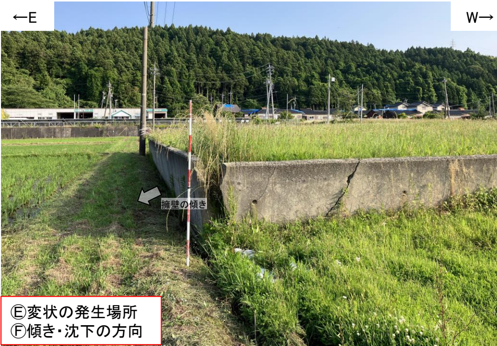
写真50(2024年6月11日撮影) 南方を望む。擁壁の東方への傾きが認められる。この変状の発生場所は、盛土の縁辺付近である。
