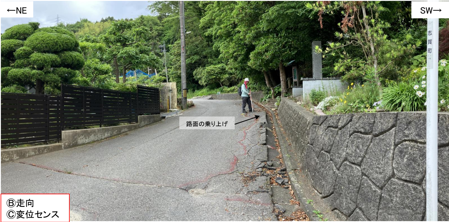
写真18(2024年6月4日撮影) 南東方を望む。地盤(アスファルト路面)が北東側(平野側)から南西側(山側)に向かって乗り上げている。路面の割目は富来川南岸断層の走向と調和的ではない方向(NW-SE方向)を示している。
