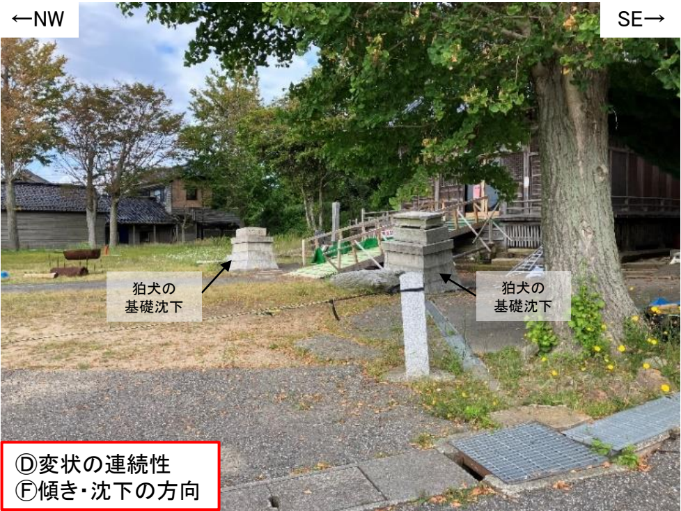
写真11(2024年6月4日撮影) 富来川南岸断層近傍の神社を南西方より望む。狛犬基礎の低地側への沈下が認められる。その周辺では、地表に顕著な変状は認められない。
