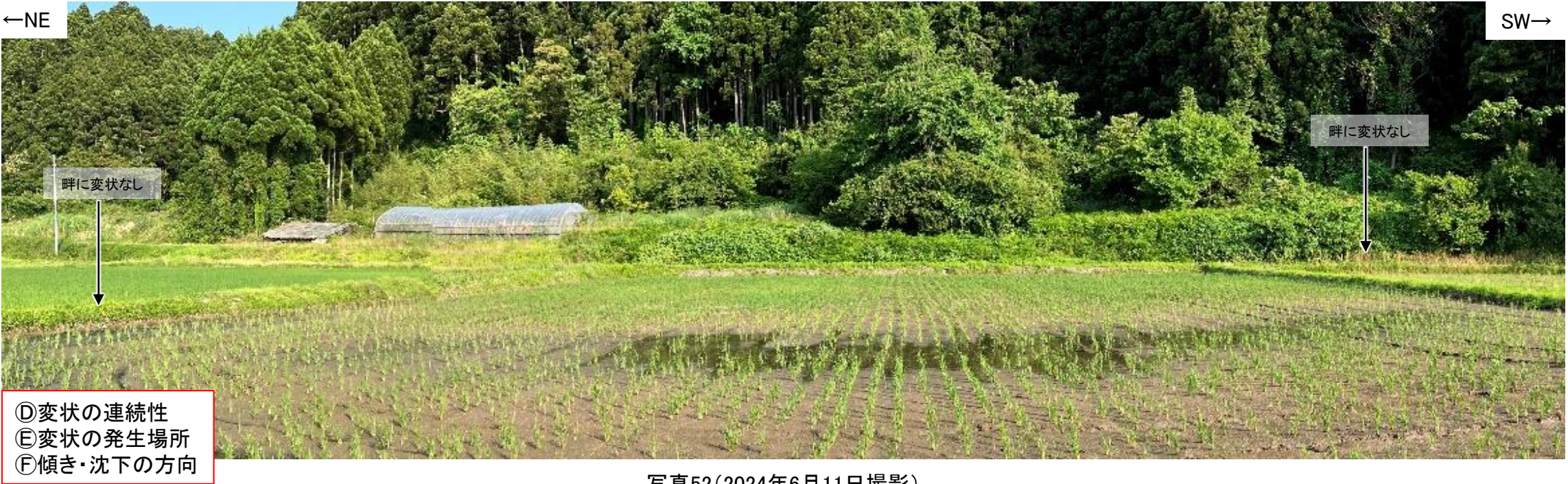
写真52(2024年6月11日撮影) 南東方を望む。田畑の富来川側(北側)に沈下(帯状の湛水)が認められる。この変状の発生場所は、盛土の縁辺付近である。この変状の東西延長部の畔には変状は認められない。
