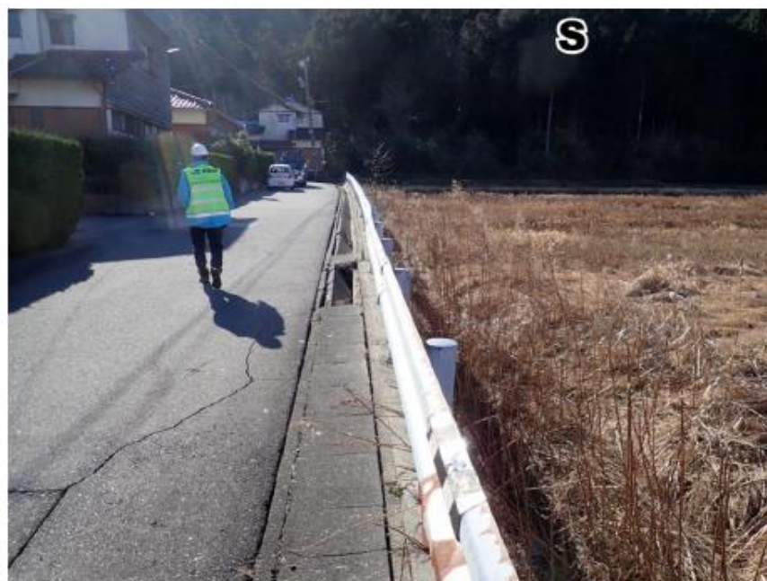
図13 盛土地盤の側方流動によるとみられるはらみ出しで生じたガードレールの見かけ上の右ずれ北に向かって撮影。(志賀町富来地頭町甲)
