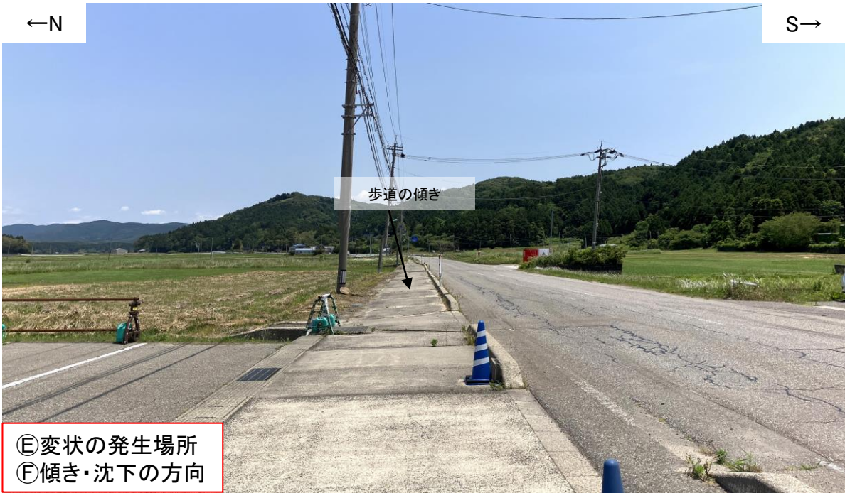
写真51(2024年6月1日撮影) 東方を望む。歩道の富来川方向(北側)への傾きが認められる。この変状の発生場所は、盛土の縁辺付近である。
