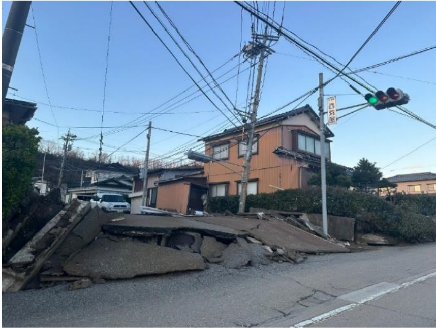
内灘町西荒屋地区における側方流動によるアスファルトの隆起(先名, 2025)
