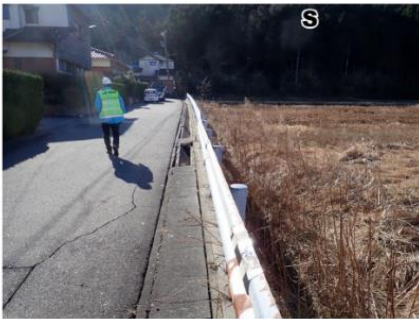
盛土地盤の側方流動によるとみられるはらみ出して生じたガードレールの見かけ上の右ずれ
