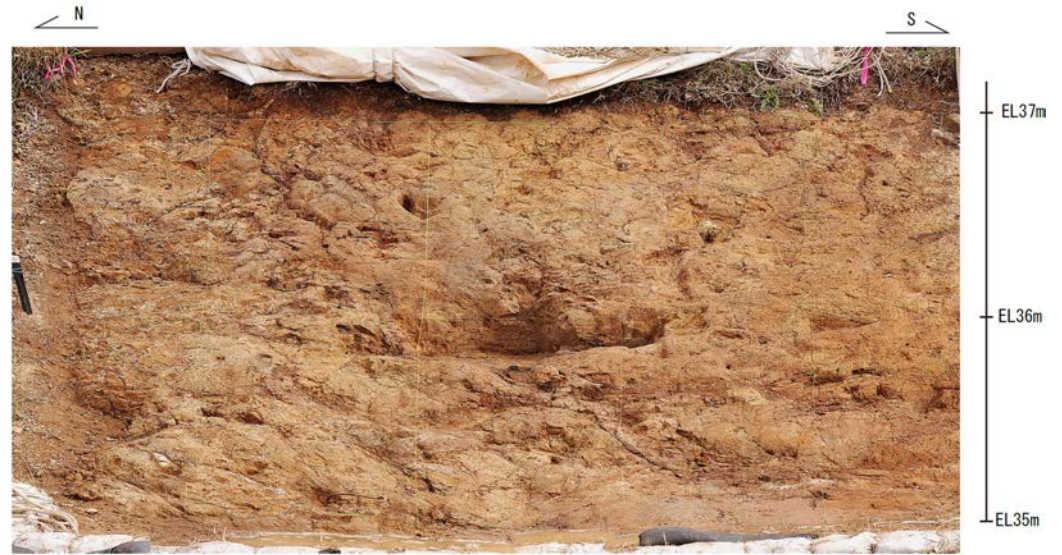
35m盤法面 写真
