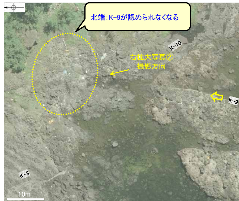
拡大写真① K-9の北方付近
