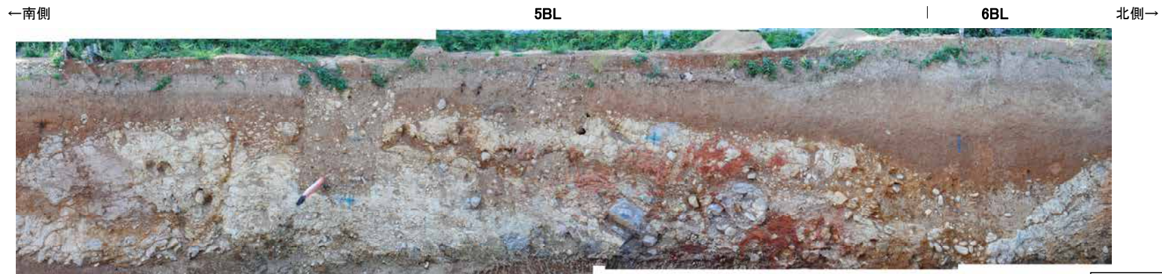
防潮堤設置時写真[5BL, 6BL]①
