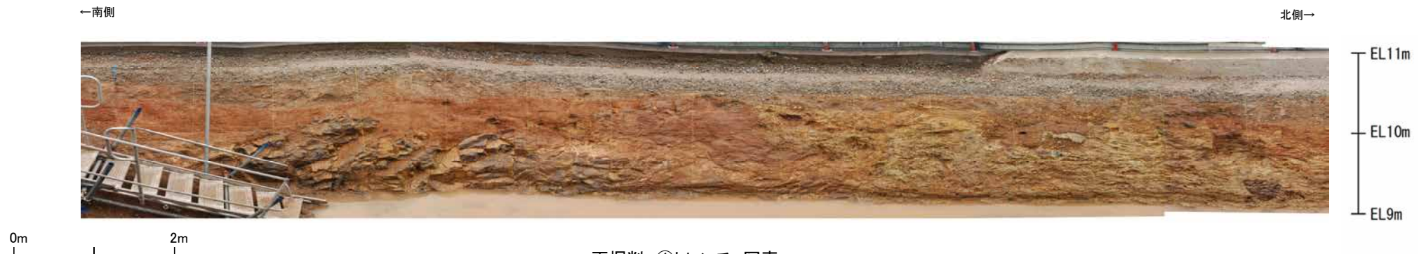
再掘削 ①トレンチ 写真
