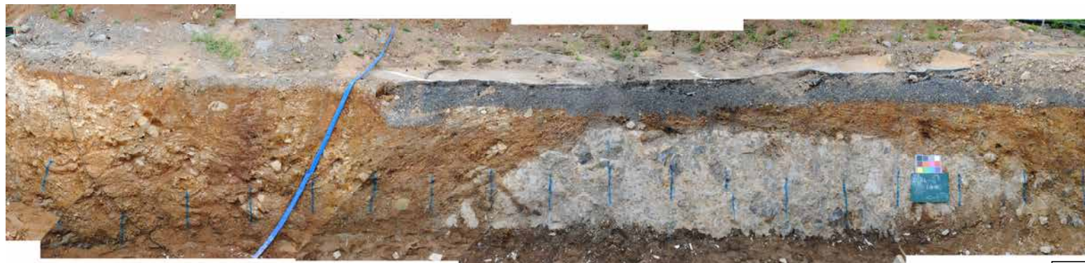
防潮堤設置時写真[25BL, 26BL]①
