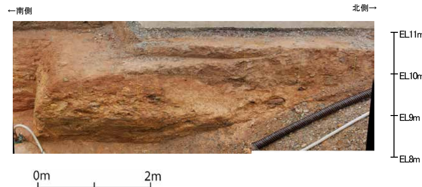
再掘削 ②トレンチ 写真
