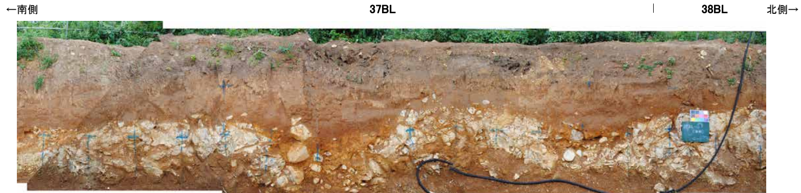
防潮堤設置時写真[37BL, 38BL]①
