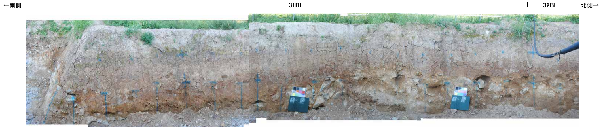
防潮堤設置時写真[31BL, 32BL]①
