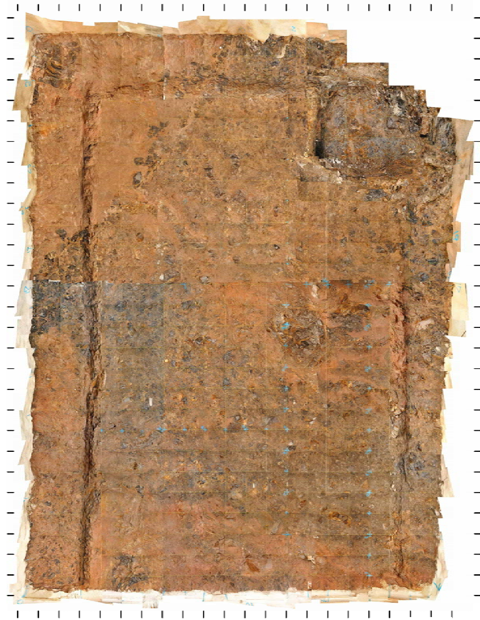
フィルタ付格納容器ベント装置建屋 基礎地盤写真
