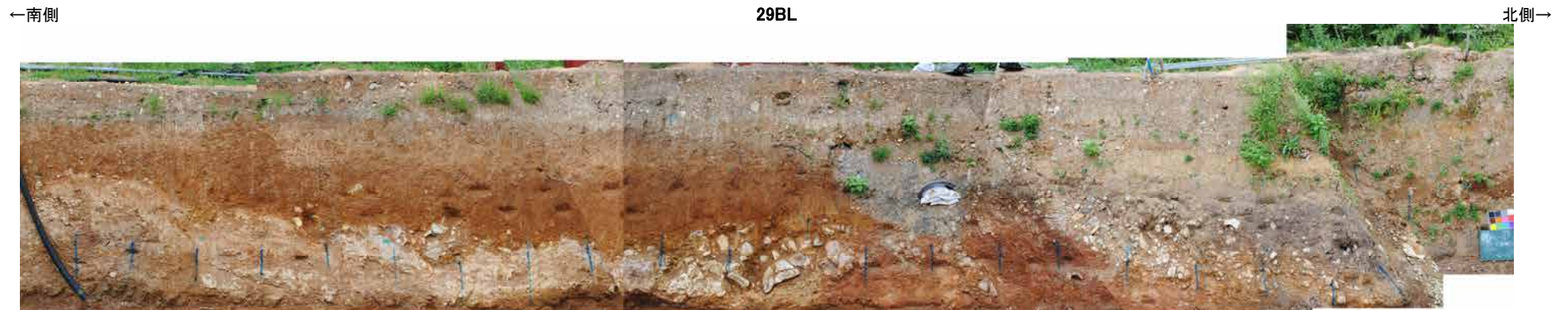
防潮堤設置時写真[29BL]
