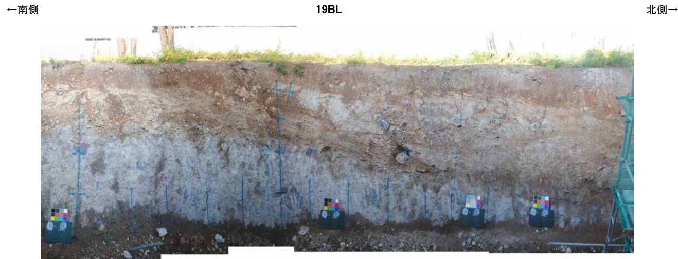
防潮堤設置時写真[19BL]
