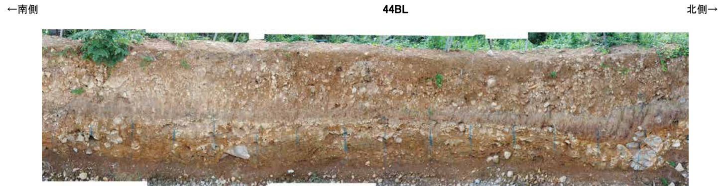
防潮堤設置時写真[44BL]
