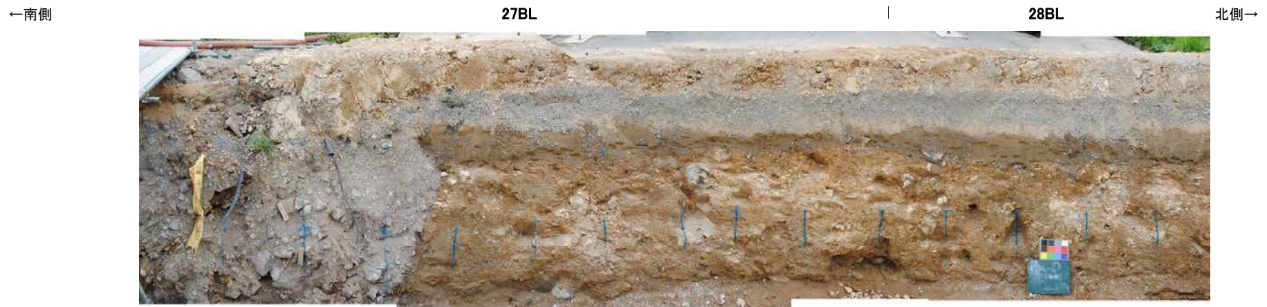
防潮堤設置時写真[27BL, 28BL]①
