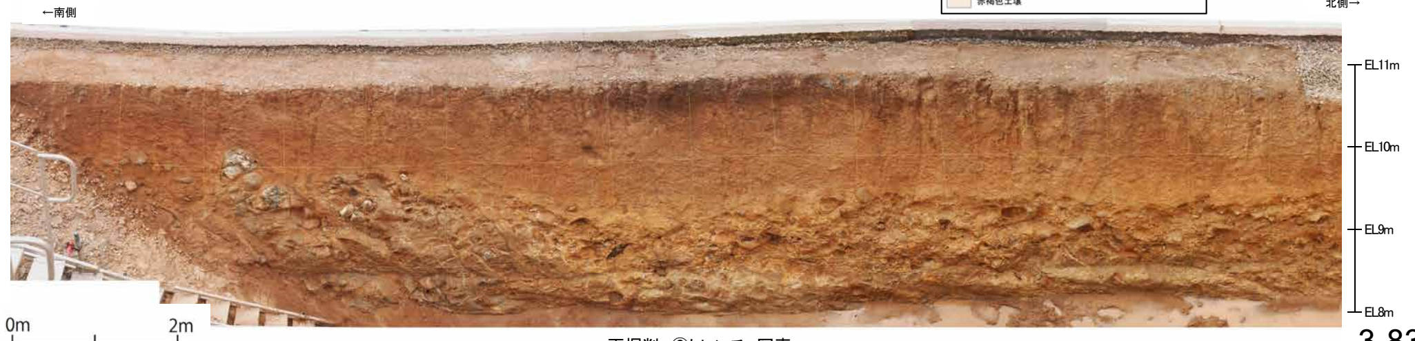
再掘削 ⑥トレンチ 写真
