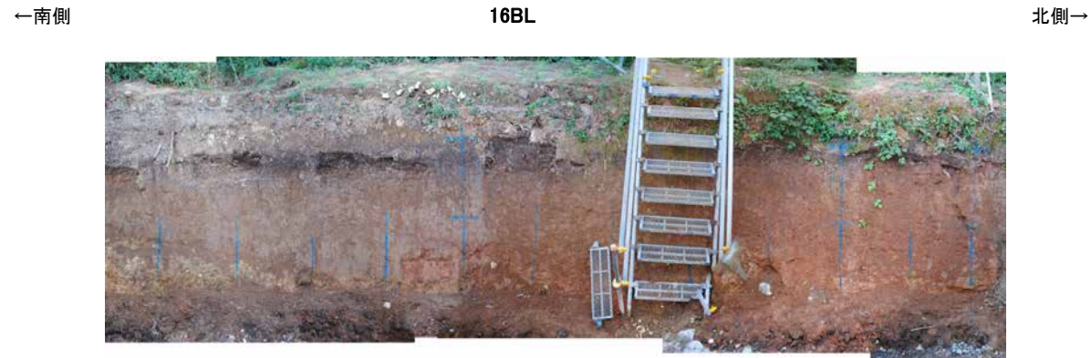
防潮堤設置時写真[16BL]
