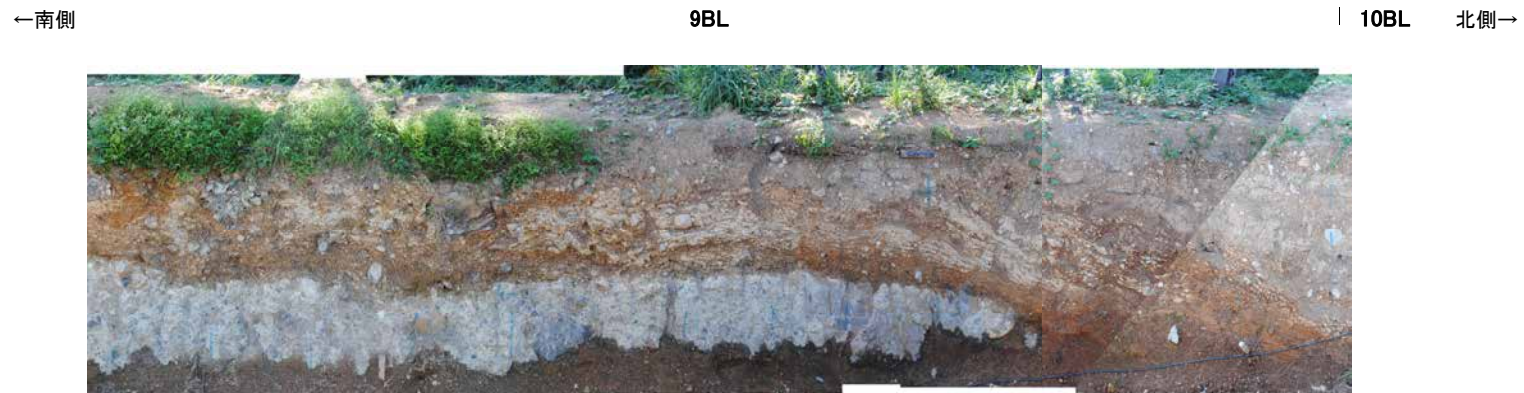
防潮堤設置時写真[9BL, 10BL]①
