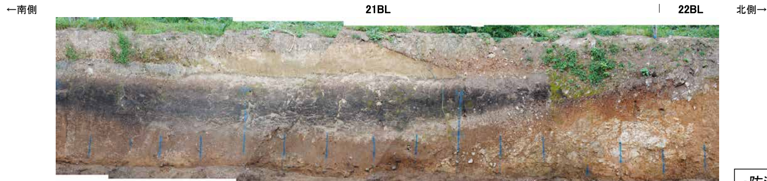
防潮堤設置時写真[21BL, 22BL]①
