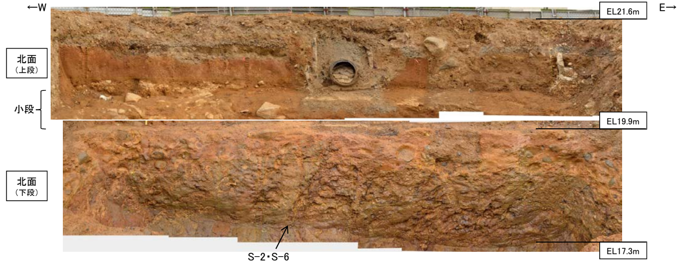
北面全景写真
