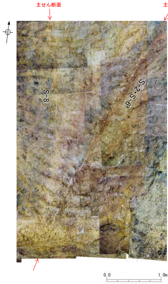
トレンチ底盤写真(拡大) S-8とS-2・S-6の会合部の状況 (海岸部との比較のため写真の向きを右に90°回転)
