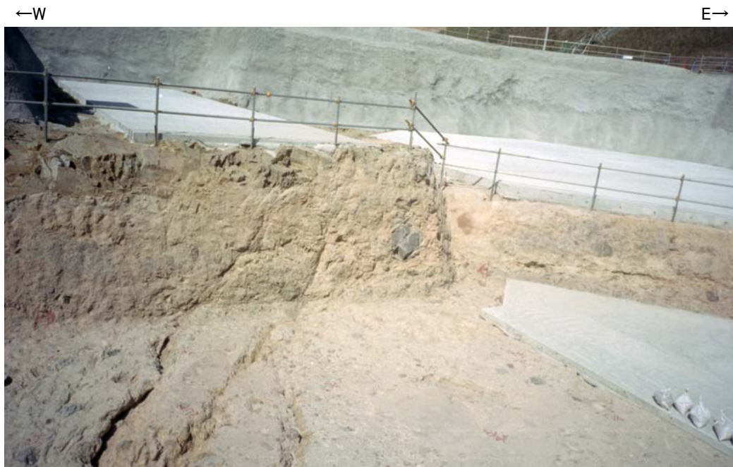
写真① S-4付近写真
