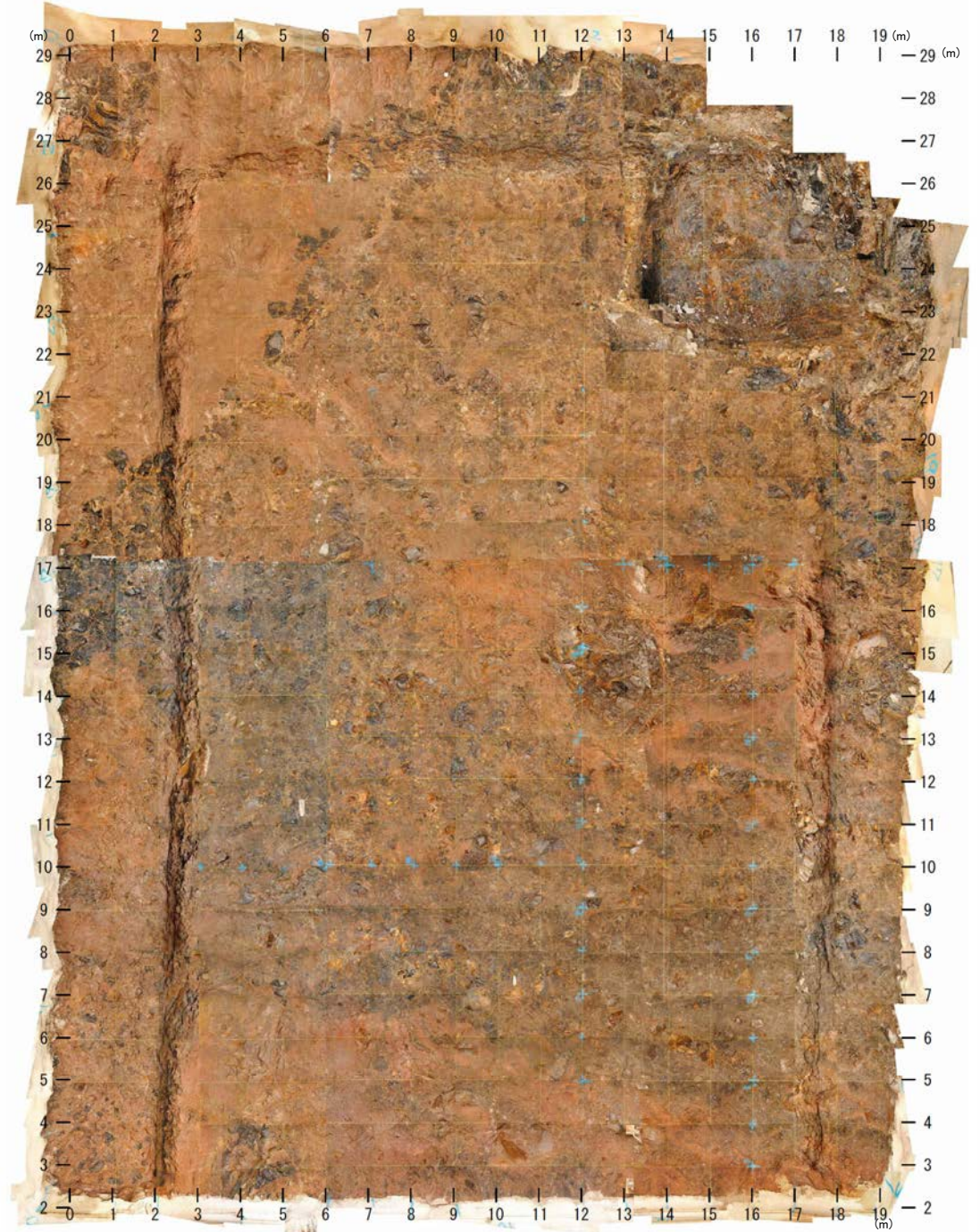
フィルタ付格納容器ベント装置 基礎底盤写真
