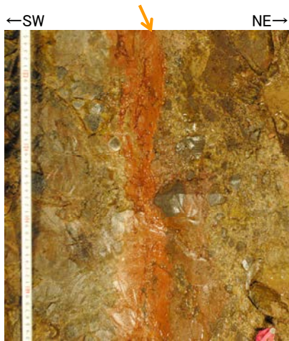
No.7付近底盤写真
