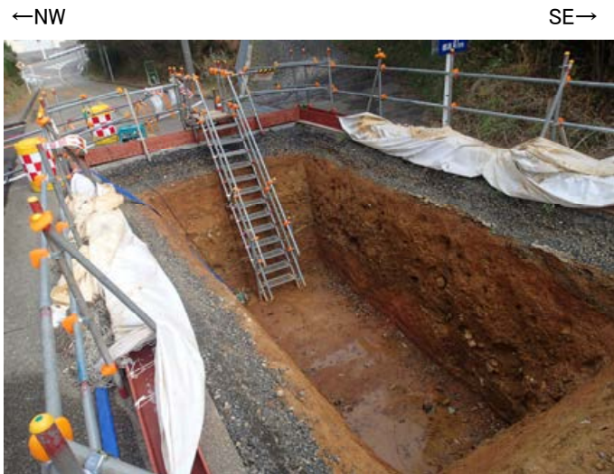
トレンチ状況写真(南西側から撮影)
