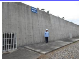
防潮堤の設置
