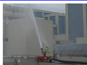
放水装置の配備
