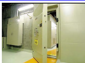
水密扉の設置
