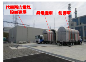
常設代替交流電源設備の設置
