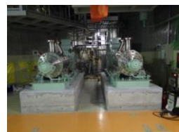
常設代替低圧ポンプの設置
