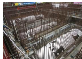
地下式軽油タンクの設置 (2017年1月)
