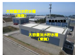
大容量淡水貯水槽の設置
