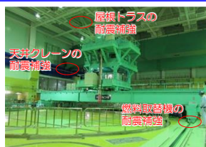
耐震安全性向上工事
