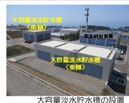
大容量淡水貯水槽の設置
