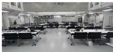
増設緊急時対策所 (内部)
