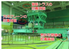
耐震安全性向上工事
