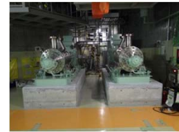
常設代替低圧ポンプの設置
