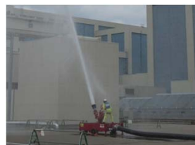
放水装置の配備
