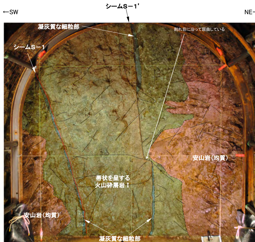
No.8切羽写真(割れ目等を加筆)
