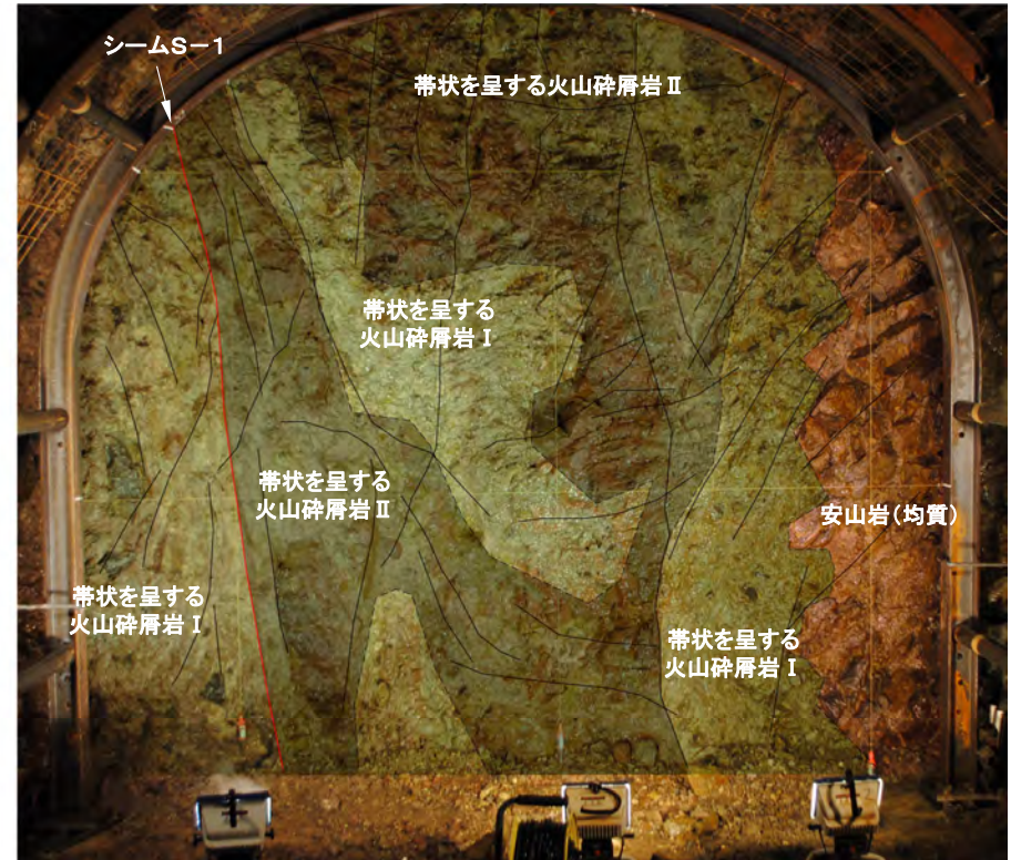
No.29切羽写真(割れ目等を加筆)
