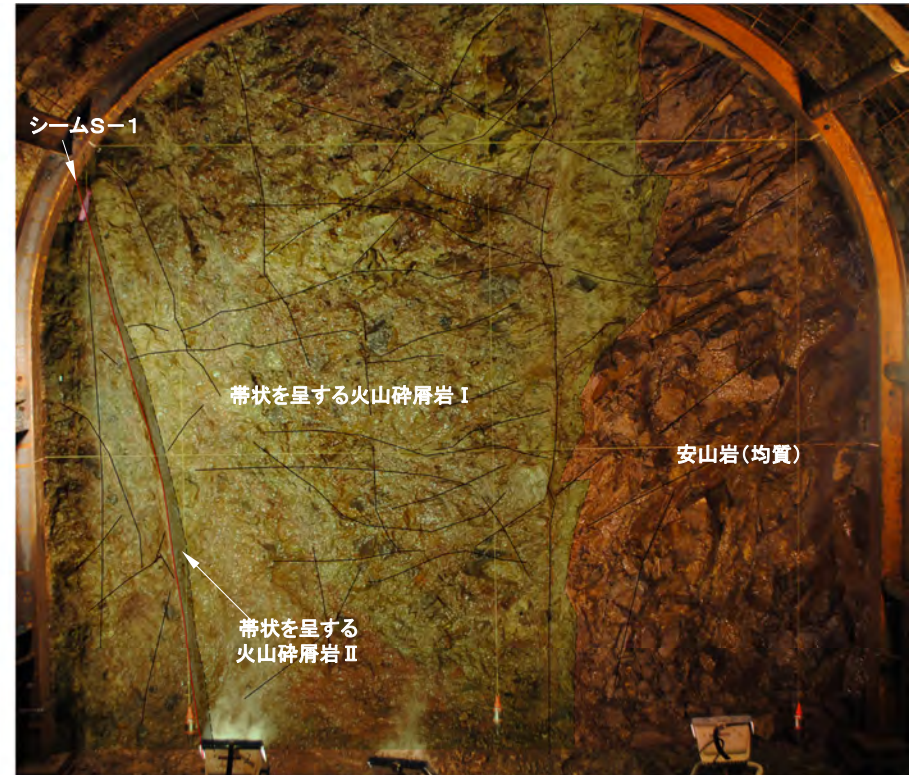
No.27切羽写真(割れ目等を加筆)
