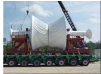
〔低圧タービン新ロータ搬入の様子〕
