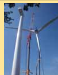
〔福浦風力発電所 風車組立の様子〕
