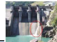
河川維持放流の状況（仏原ダム）
