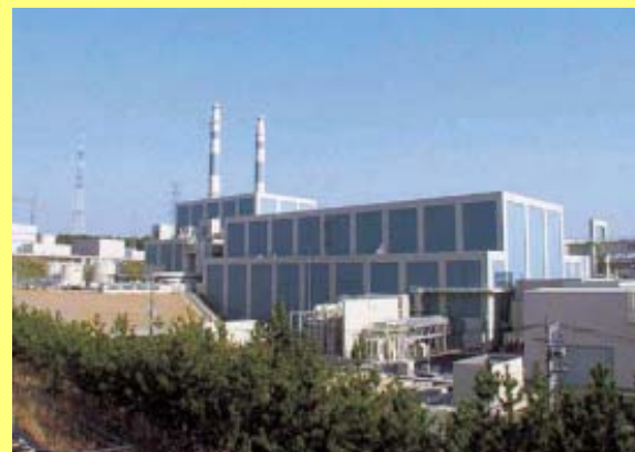
志賀原子力発電所(奥:1号機、手前:2号機)
