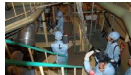
【志賀1号機 耐震裕度向上工事】
