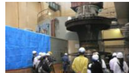
【神通川第二(水力)発電所修理工事】
