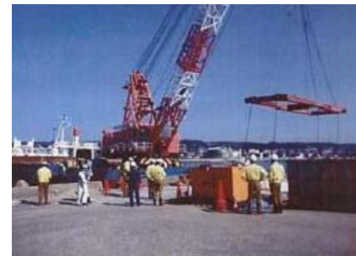
【現場パトロール(土木)】
