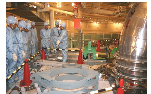
【耐震裕度向上工事】
