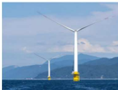
北陸地域初の洋上風力となる入善洋上風力発電所
