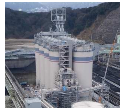
敦賀火力発電所燃料貯蔵サイロ(設置完了)
