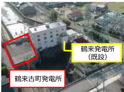
鶴来古町発電所
