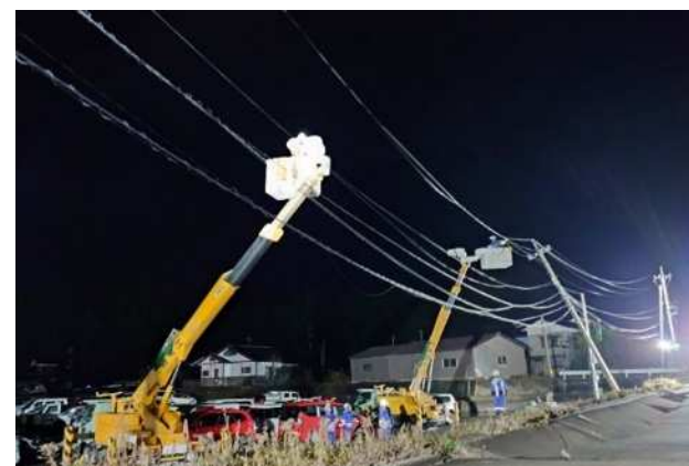
応急復旧工事（電柱傾斜改修）
