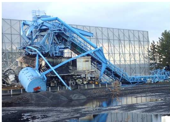
払出機が倒壊
