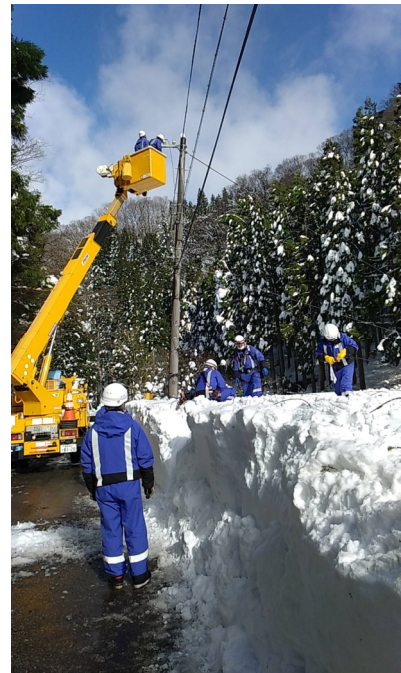
停電復旧作業
