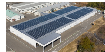
福井銀鯉(株)さまへの太陽光発電設備の設置
