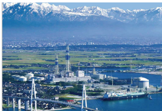
富山新港火力発電所
