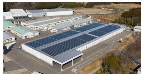
福井県鯖江市さまに導入された太陽光パネル
