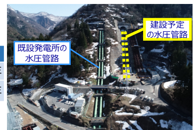
新姫川第六発電所の建設状況 (2021年3月、新潟県糸魚川市)
