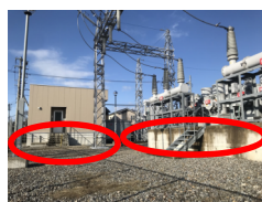
建物および開閉装置の高上げ
