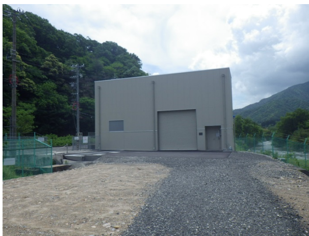
足田発電所 全景
