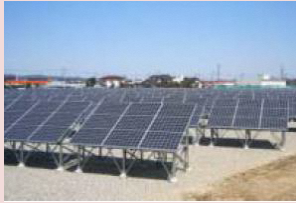
富山太陽光発電所 (太陽光パネル)
