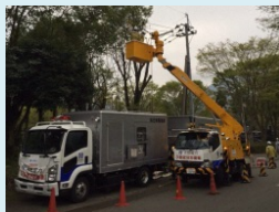
災害時の停電復旧作業
