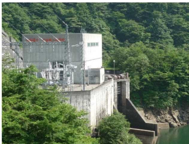
有峰第二発電所 全景
