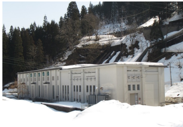
尾口発電所 全景
