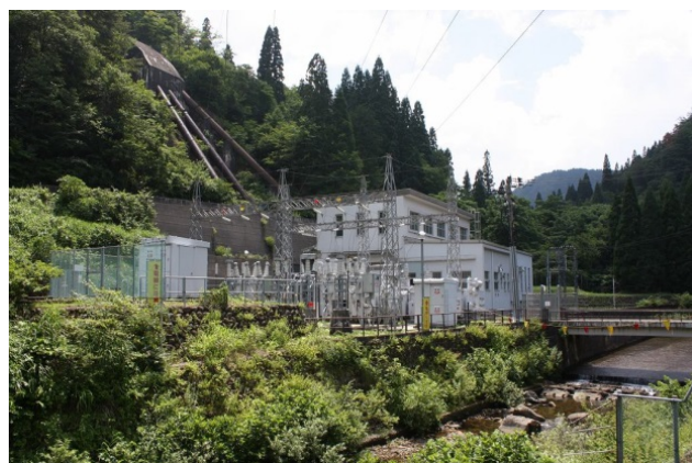
白峰発電所 全景
