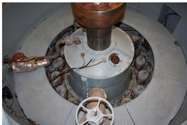
中島発電所 水車
