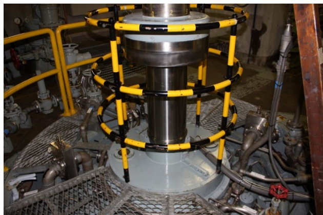
白峰発電所 水車
