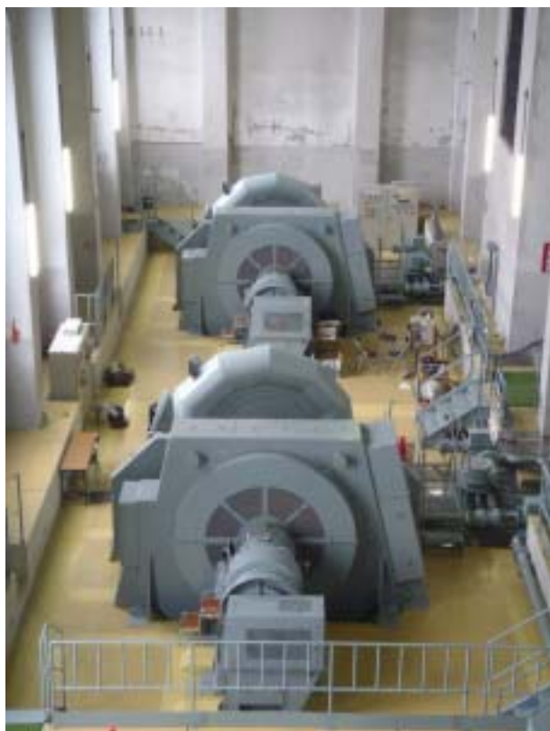
改修後の1・2号水車・発電機（奥側が1号機）
