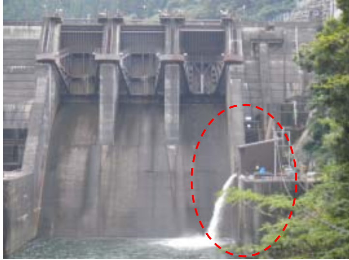
仏原ダム発電所
