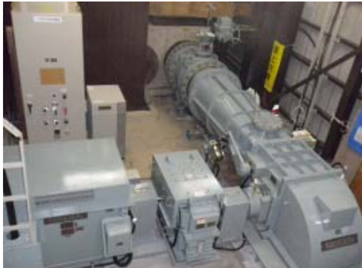
発電所内部の状況
