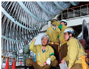
火力発電所定期検査
