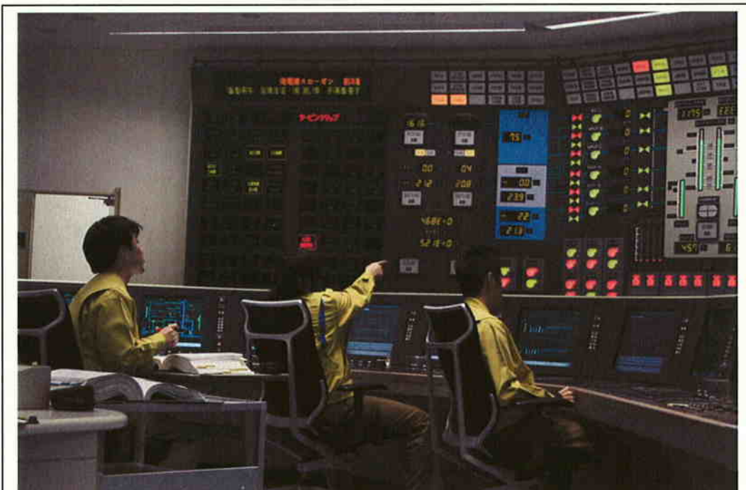
中央制御室にての原子炉起動操作風景
