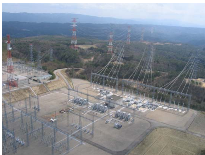
中能登変電所
