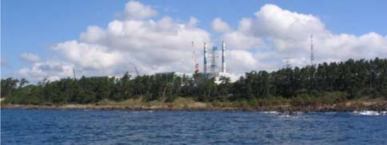
緑で囲まれた発電所
