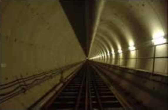
海底トンネルの内部
