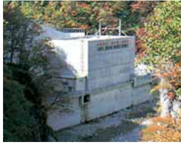
▲有峰第一発電所 水車1基の出力(26.5万kW)が日本で最大の一般水力発電所
