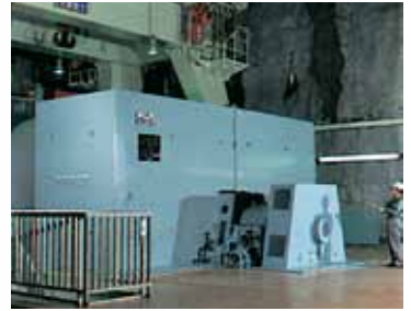
▲有峰第三発電所 地下式では当社で唯一の水力発電所
