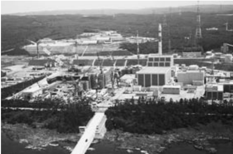
志賀原子力発電所
