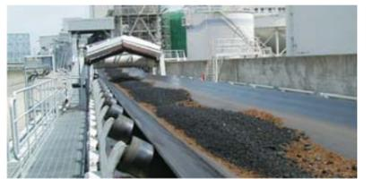
敦賀火力発電所2号機 木質バイオマス混焼燃料搬送状況 (石炭+木質バイオマス)
