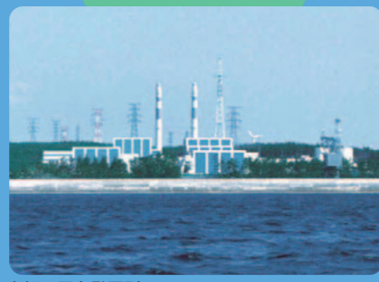
志賀原子力発電所
