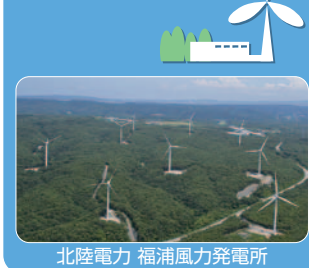
北陸電力 福浦風力発電所
