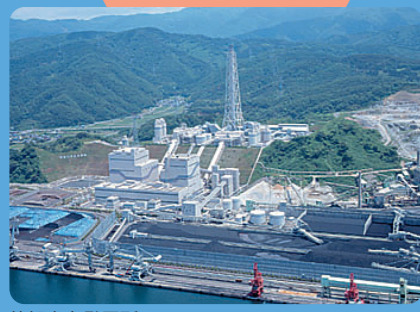
敦賀火力発電所
