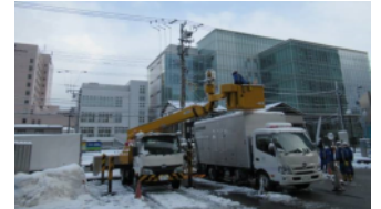
▲高圧発電機車による送電（富山市）
