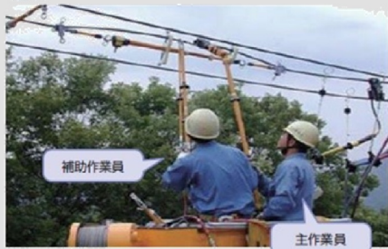
配電工事用ロボット（アシストアーム）の適用
