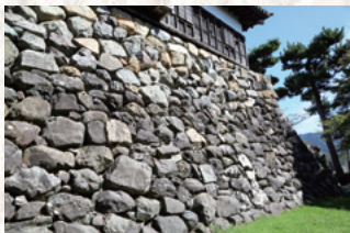
川の丸みのある石を使用し小さな石で すき間を埋めた、野面積みの石垣
