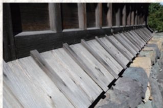
外壁から伝わった雨が入りの中に入るのを 防ぐ、水切り屋根
