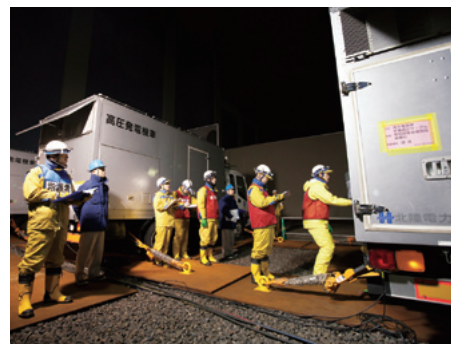
夜間の電源接続訓練
