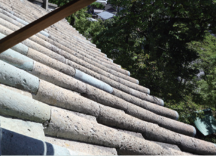
修復時、石川産の石も使用された。 青い部分が笏谷石でできた石瓦
