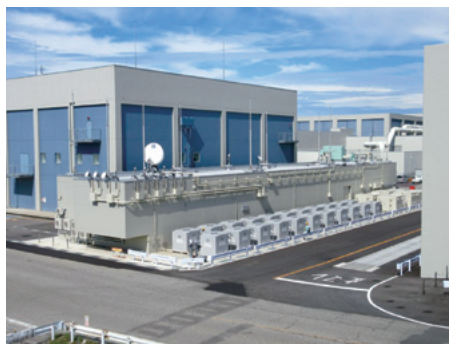
重大事故等発生時の対応拠点となる 緊急時対策棟・増設緊急時対策所(指揮エリア)
