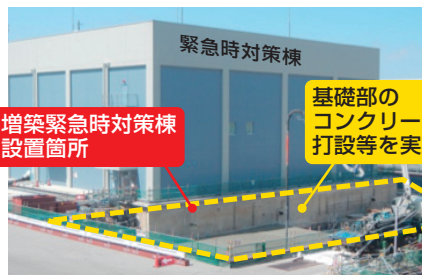
工事状況 (平成27年4月現在)
