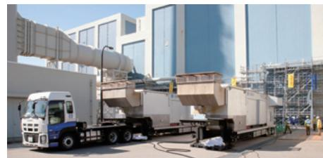
監視・注水冷却の他、海水により循環冷却する設備等の電源を確保するため、非常用電源(大容量)を標高21mに配備しました。(4,000kVA×2台)
