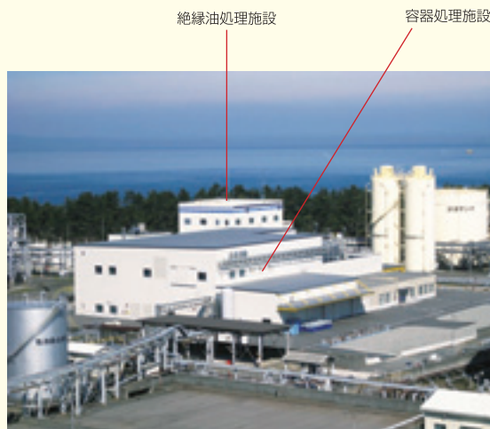
変圧器リサイクルセンター全景
