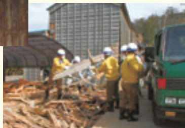
がれきの撤去作業（輪島市）
