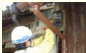
地震被害地域のお客さま宅の配線点検
