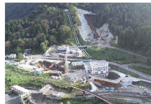
[新姫川第六発電所の建設状況（2019年9月）]
