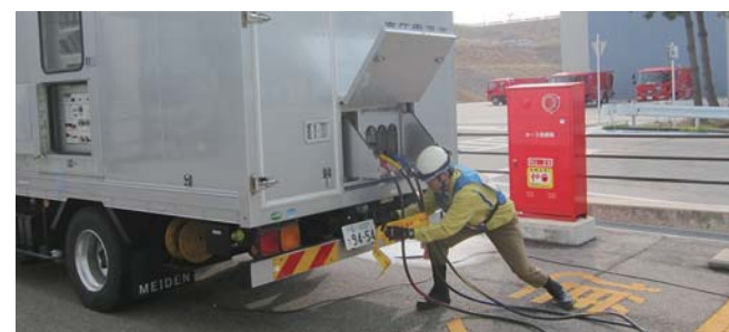
高圧電源車による給電訓練 高圧電源車を使用した緊急時対策所への給電を行う訓練
