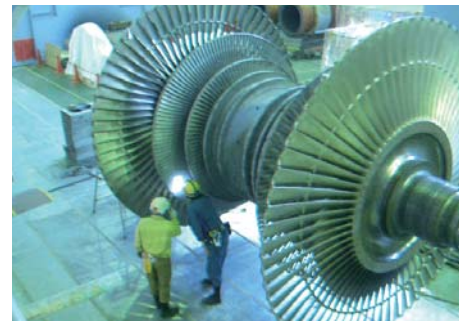
火力発電所定期点検の様子
