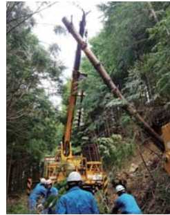
倒木処理、被害設備の撤去
